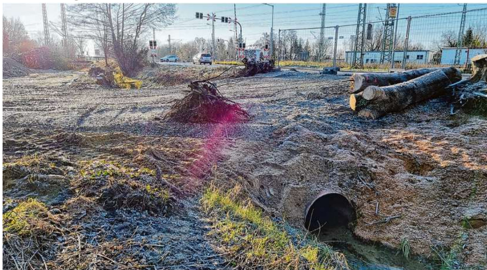
Zufahrt zur Baustelle am Ortseingang von Lübbenau. Hierfür musste ein Fließ verrohrt werden. Im Hintergrund die beschränkten Bahnübergänge.
